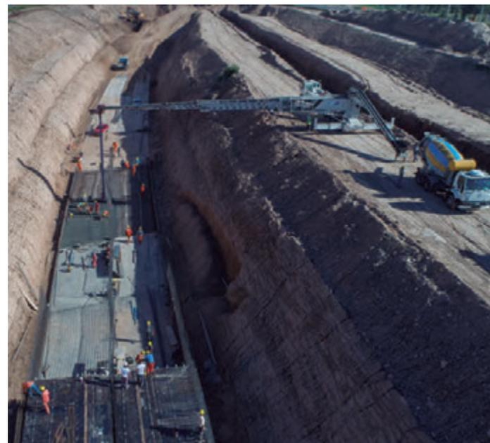
Detalle del momento de hormigonado de la avenida en trinchera. En la imagen de la derecha se puede apreciar la gran altura del talud que se debió excavar para permitir los pasos a nivel de avenida Donosa y del tendido ferroviario que se ubica a esa altura.
