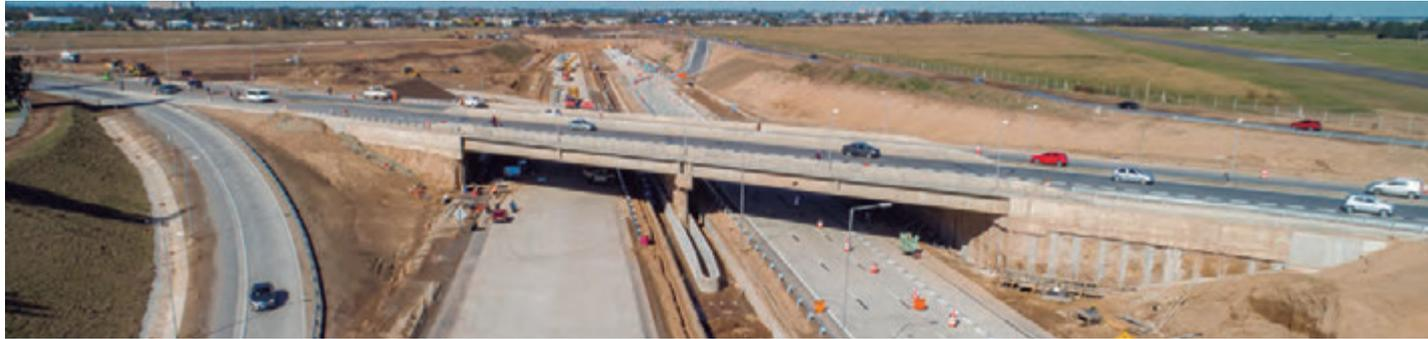
Vista de los voluminosos trabajos de movimiento de suelo. En el centro de la excavación ya se puede apreciar la obra hidráulica que se ubica por debajo de las vías de circulación.
