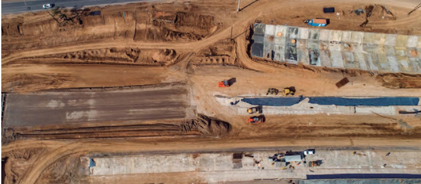
Proceso constructivo: canales abiertos de desagüe y movimiento de tierra.
