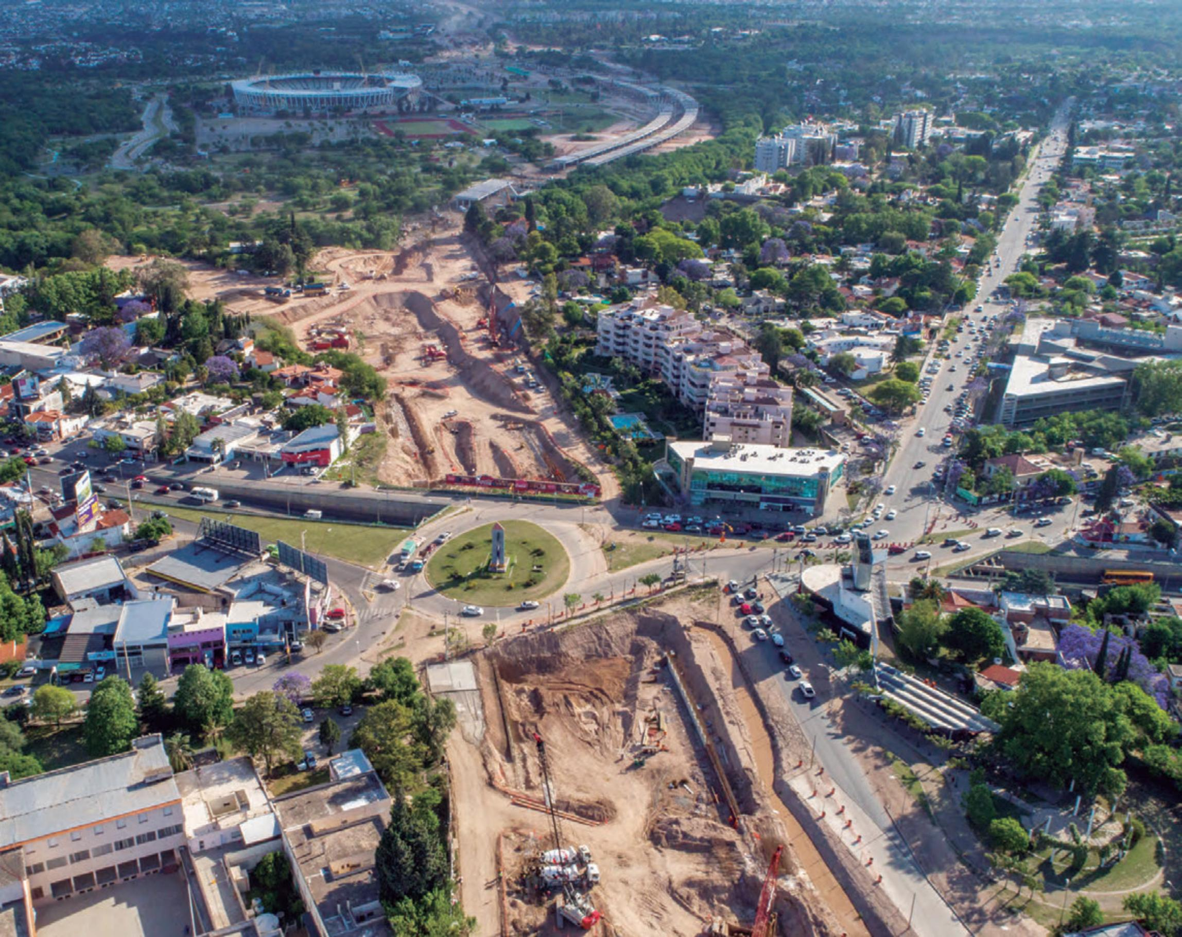
Detalle del conducto soterrado de desagüe de 3mts. de ancho por 2 mts. de alto y 1.9 km. de longitud total.
