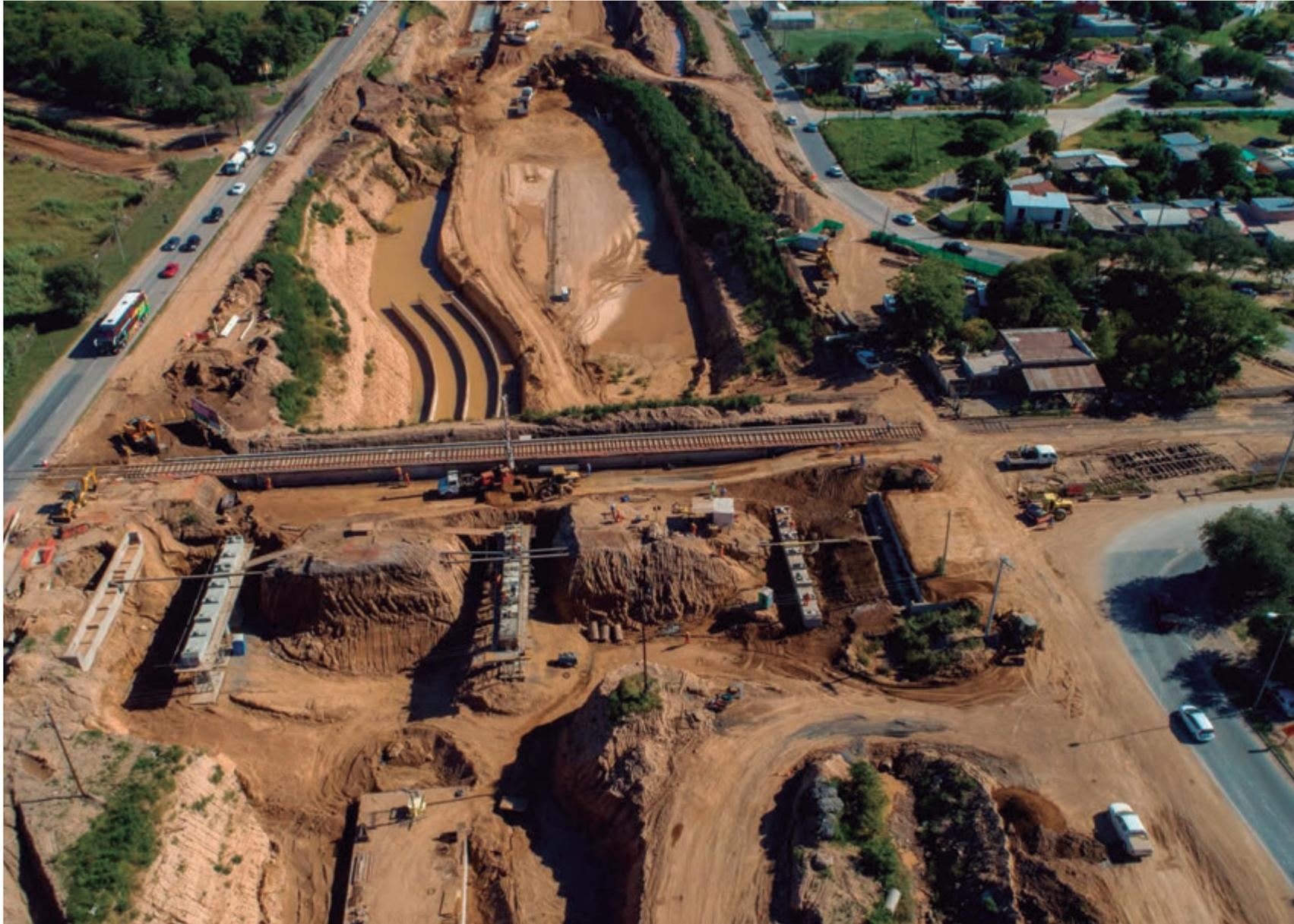
Inicio de las excavaciones para desagües pluviales y para la realización del puente que dará continuidad al ramal ferroviario.
