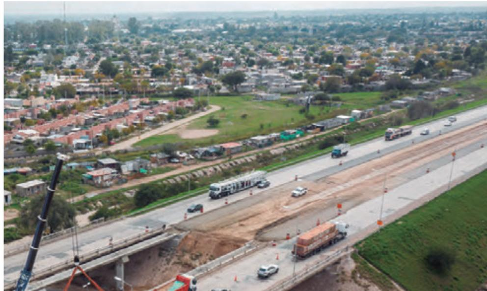
Vista y detalle de la obra en los puentes sobre el río Suquía. La obra avanzaba con las tareas que requerían corte total de calzada en turnos nocturnos, a fin de no complicar la circulación.
