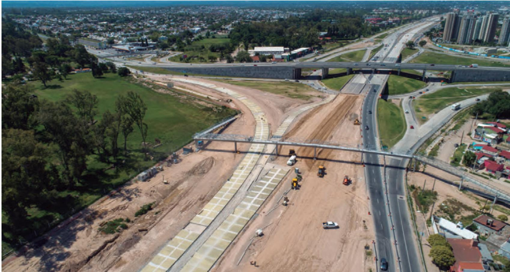
Obras de pavimentación y movimiento de suelos en la vinculación hacia el sur con el nudo El Tropezón.
