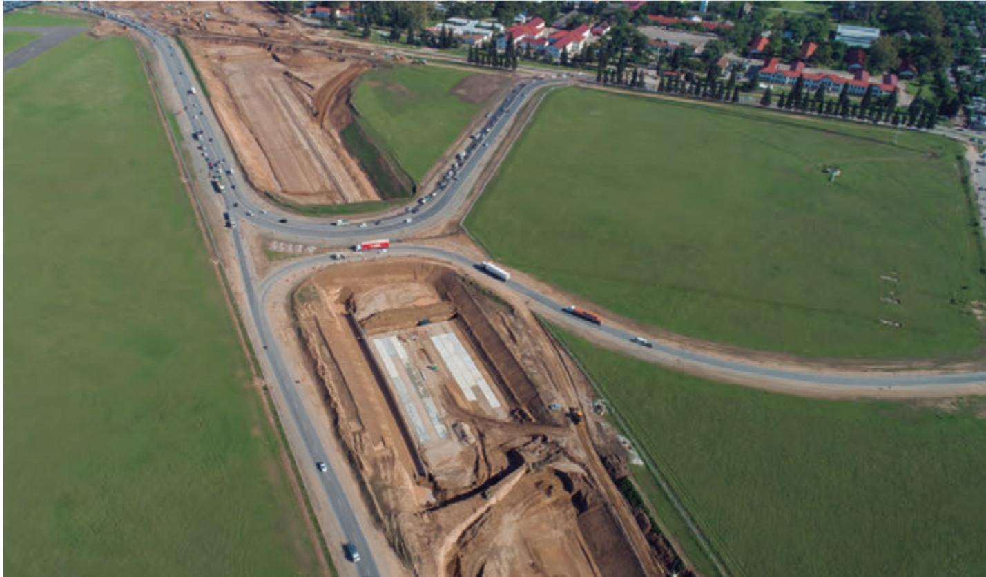
Avance de obra del trayecto en trinchera que atraviesa los terrenos de FAdA en el sector de la pista, realizado por dos empresas. El muro de tierra que se ve en las imágenes, fue lo último en nivelarse, este señalaba el límite entre dos empresas y sobre él se planteó el desvío de tráfico que se mantuvo constante durante todo el desarrollo de la obra.
