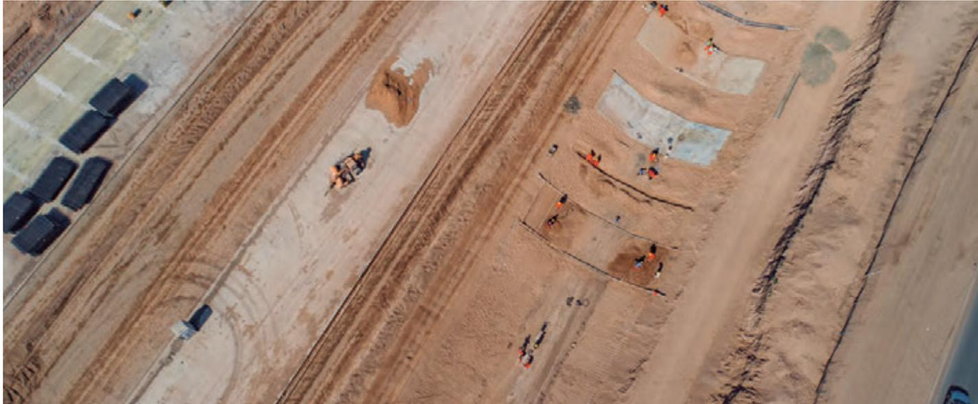
Proceso constructivo de los canales de desagüe y preparación de suelo para el trazado y construcción de las vías.
