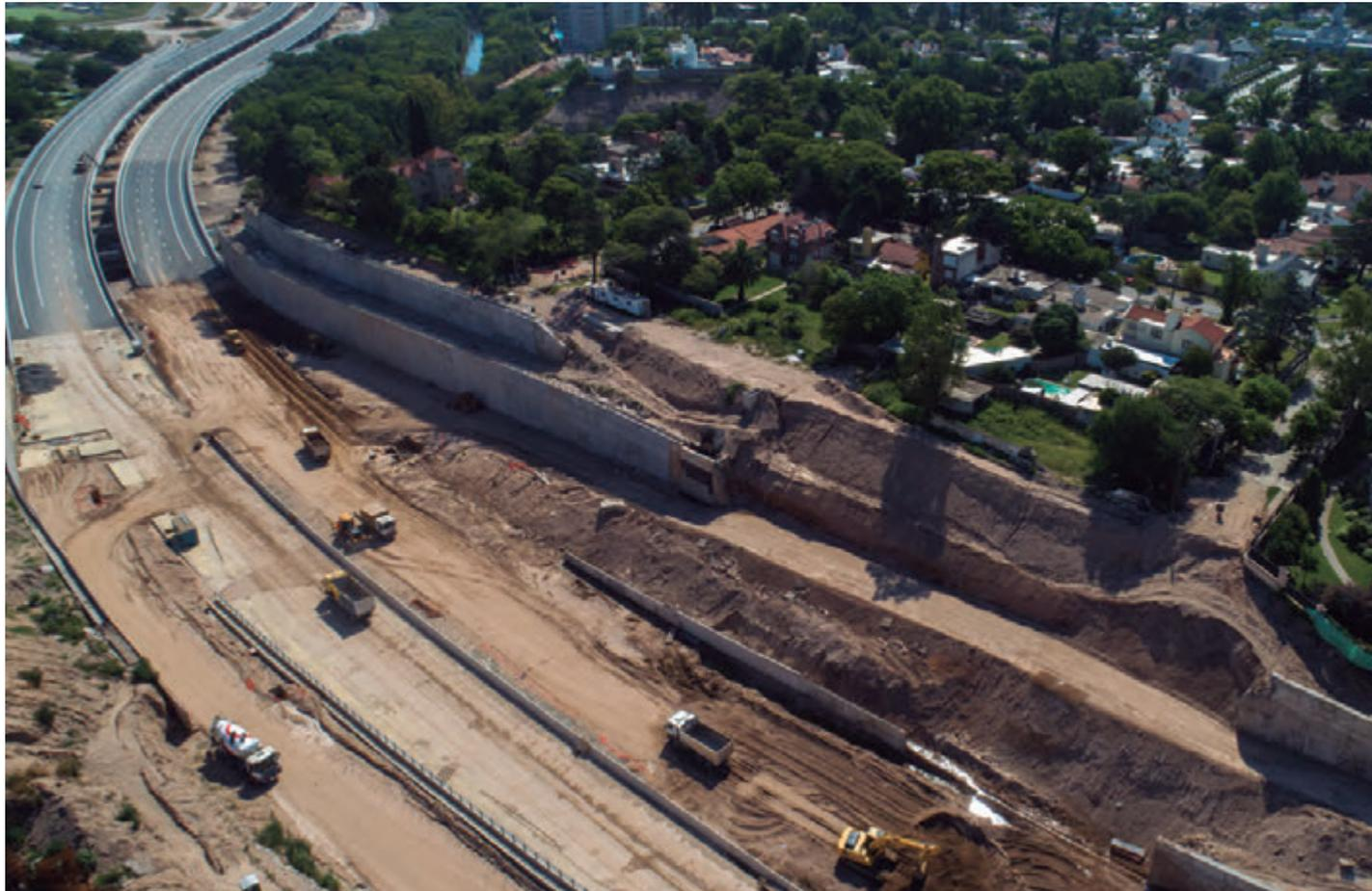
Pág. 104.: Vista de la bajada hacia el río desde el túnel en la que se aprecia el volumen e importancia de los desagües previstos hacia el río.
