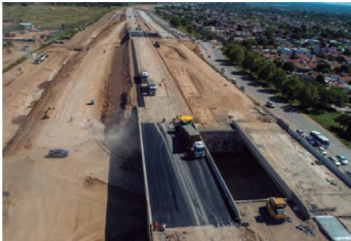
Construcción de losas de hormigón y carpeta asfáltica de colectoras.
