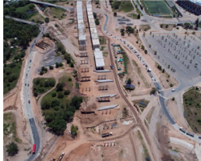
Armado de los pórticos. Éstos varían en altura y diseño, adaptándose a los desniveles y resistencia del terreno natural. Es por ello que varían también en la cantidad de columnas, de entre tres y cinco por pórtico.
