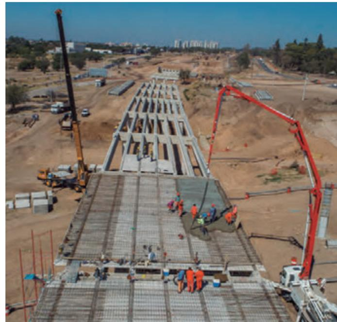
Proceso completo de realización de losas: colocación de encofrado perdido, armadura metálica y colado del hormigón elaborado. Momento del colado de los 20 cm. de espesor del hormigón que vincula los pórticos.
